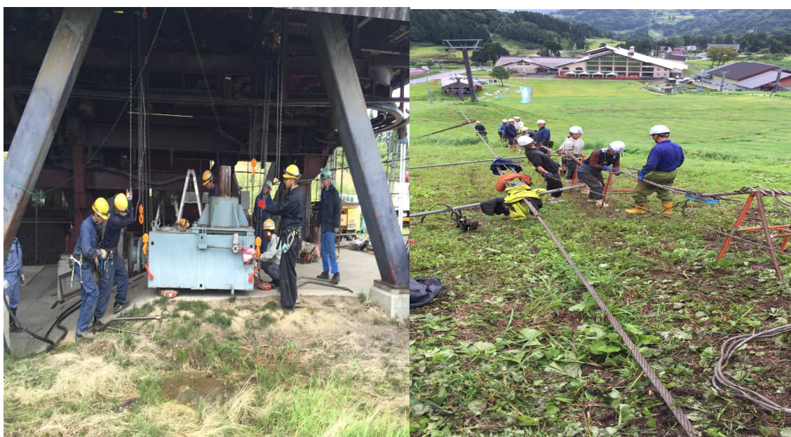
第2クワッドリフト原動機OH工事、
