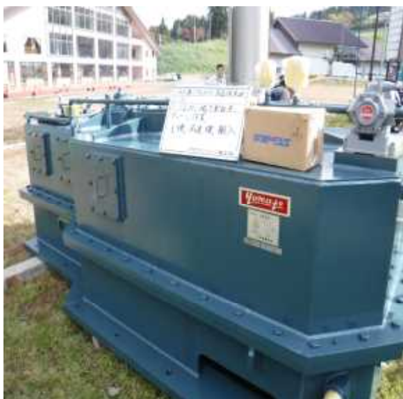
第 1 クワッドリフト減速機更新
