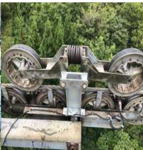
ゴンドラ脱索防止輪修繕
